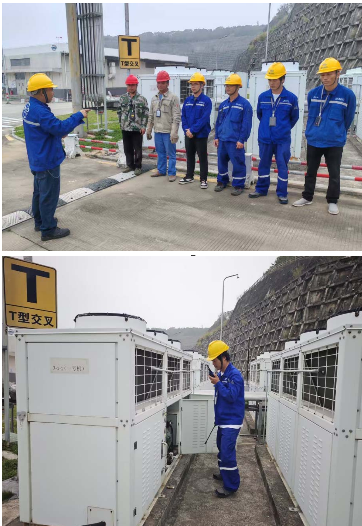
图 F2.2-1 7#库储液器氟利昂泄漏应急处置演练照片
