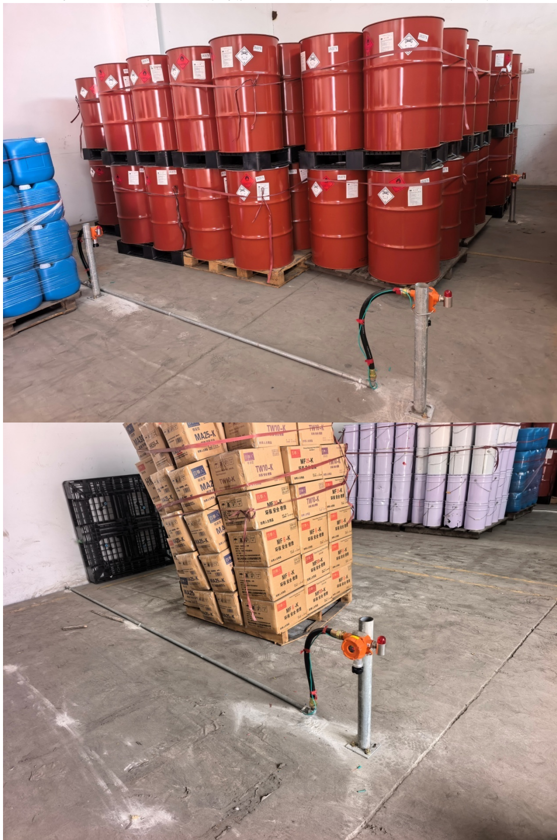
附图 4 2#仓库、3#仓库可燃/有毒气体探测器均按标准的要求设置
