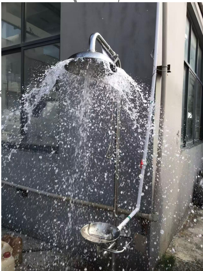
附图 7.3.5-4 已调整装车区的洗眼器供水压力，能满足使用要求
