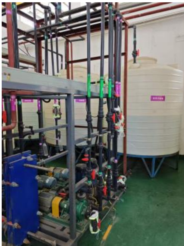
附图 1 再利用湿法车间管道已设置物质名称和流向的标识
