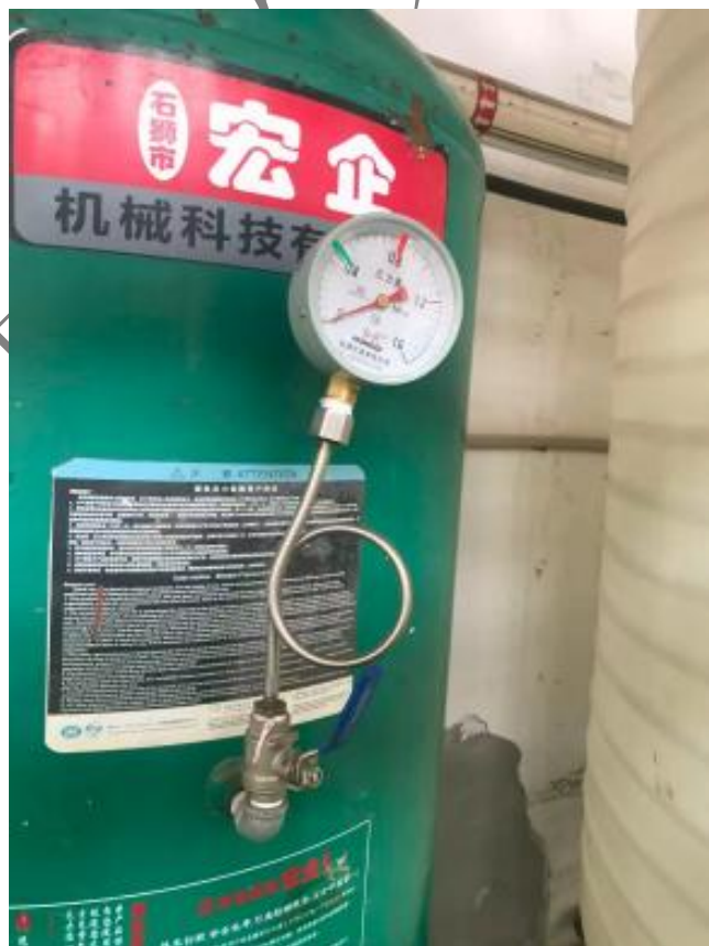
附图 2 再利用湿法车间简单压力容器上的压力表在刻度盘已划出指示工作压力的红线
